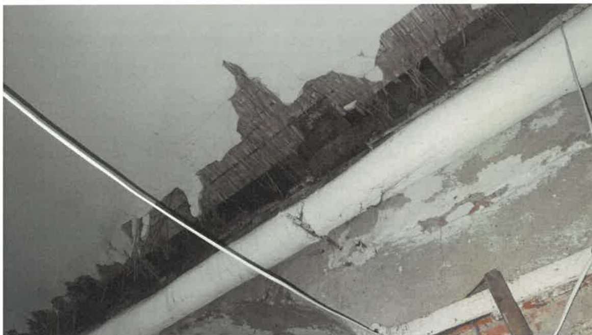
Fot. 3 – Uszkodzenia stropu drewnianego
