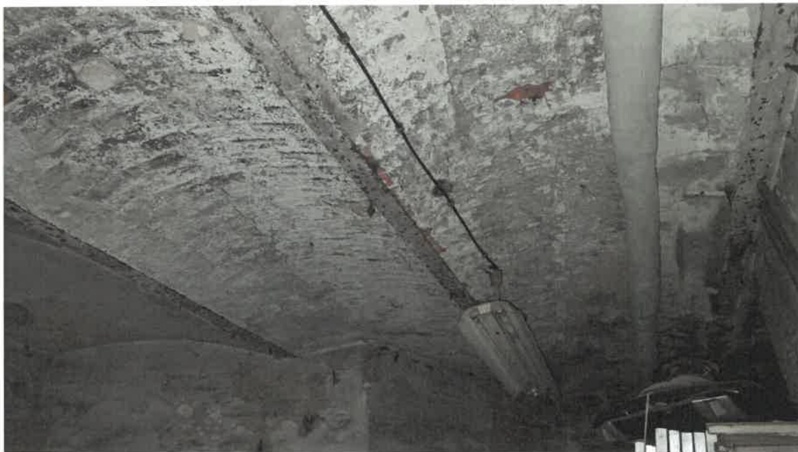
Fot. 1 – Zdegradowane stropy odcinkowe na piwnicą
