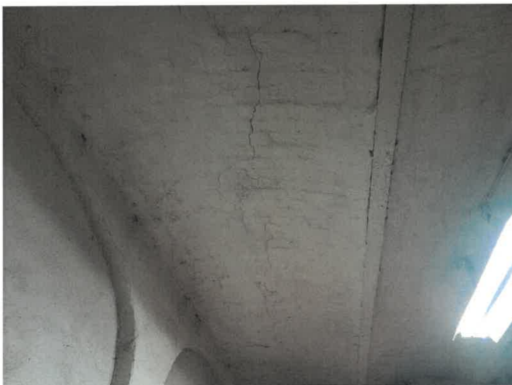
Fot. 2 – Uszkodzenia stropów odcinkowych
